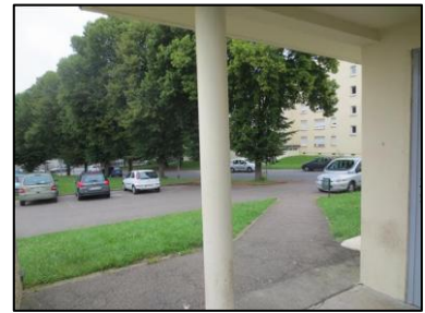
Photo N° 1090 AMIANTE CIMENT - -HALL EXTERIEUR Poteaux Coffrage perdu
